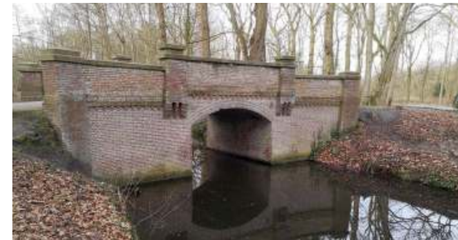
Een van de bruggen van de parkenroute. Foto 2021.
