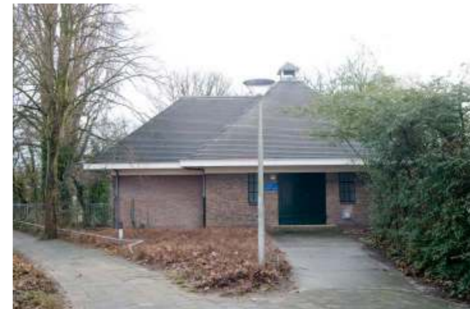
Afvalwatertransportgemaal op Van Zuylen van Nijveltstraat 83. Foto 2012.
