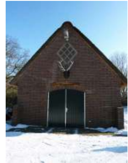
Dienstgebouw Meijnhof met werkplaats en dienstwoning. Foto 2012.
