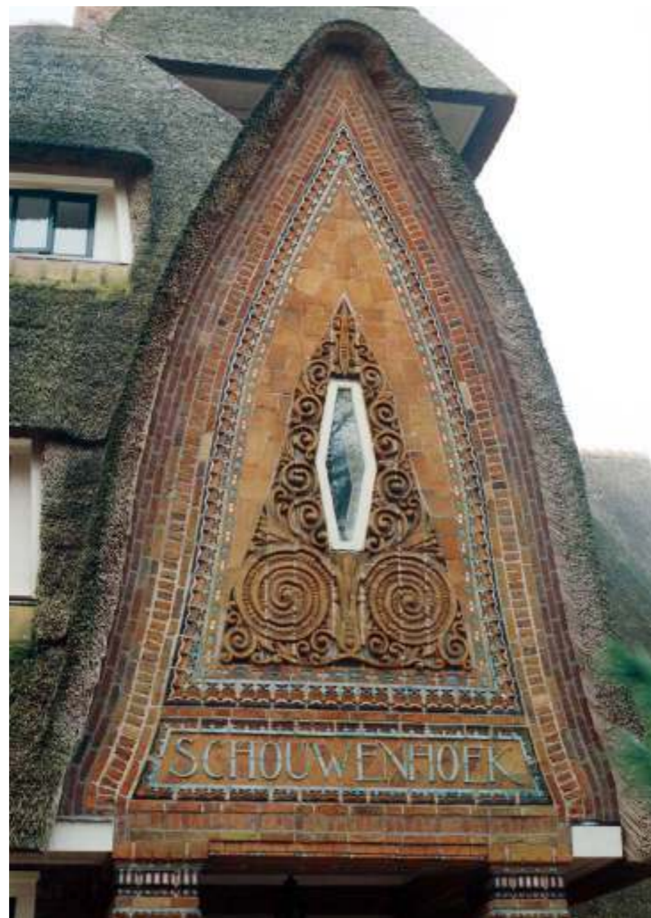
Detail geveltop van de entree van Schouwweg 102. De entree valt op door het rijke bouwaardewerk, uitgevoerd door de firma W.C. Brouwer, met invloeden uit de batikcultuur. Foto 2003.
