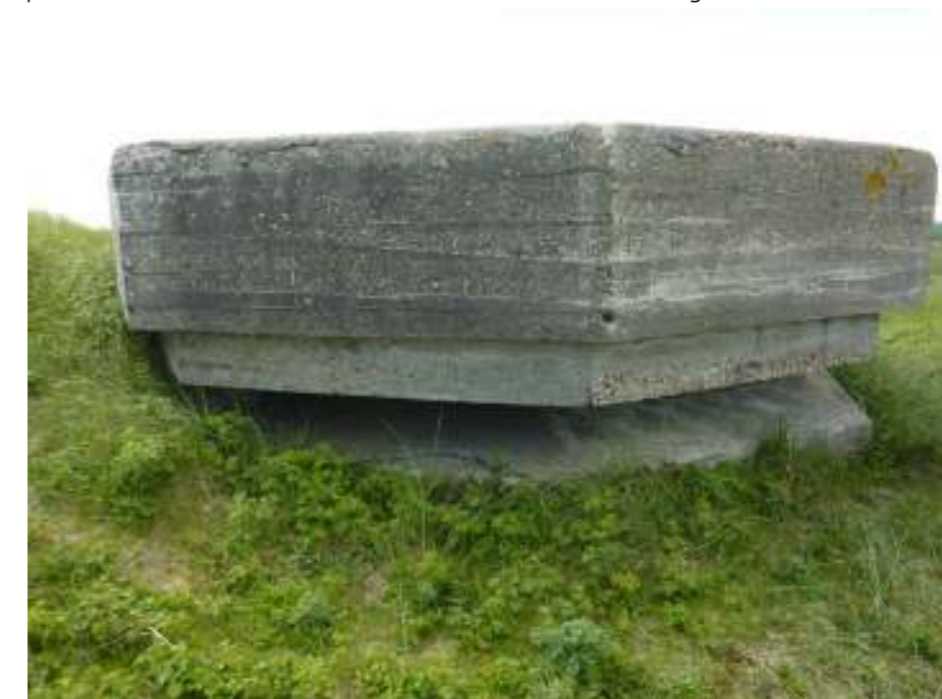
Bunkerelement D 19 van de Vleermuisbunker. Foto 2013.
