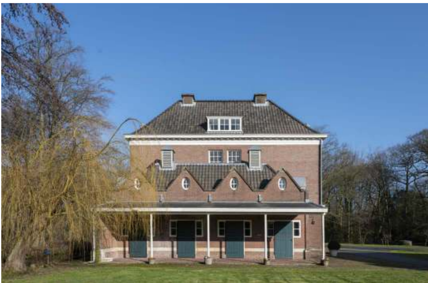
Villa Ruys heeft als laatste generatie buitenplaatsen een koetshuis met een garage en chauffeurswoning. Foto 2019.
