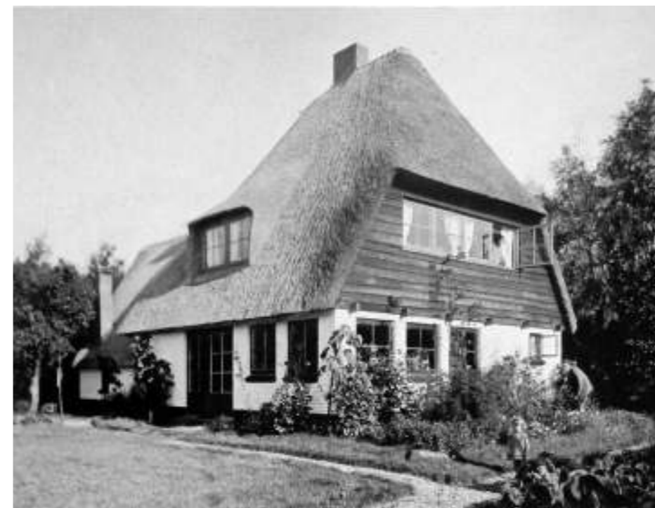
Atelierwoning Papeweg 42 is ontworpen in cottagestijl met een rieten kap en houten rabatdelen tegen de kopgevel; de grote raampartij op de noordwestzijde is nodig voor de juiste lichtval in het atelier. Foto ca 1930. Bron: J.G. Wattjes.
